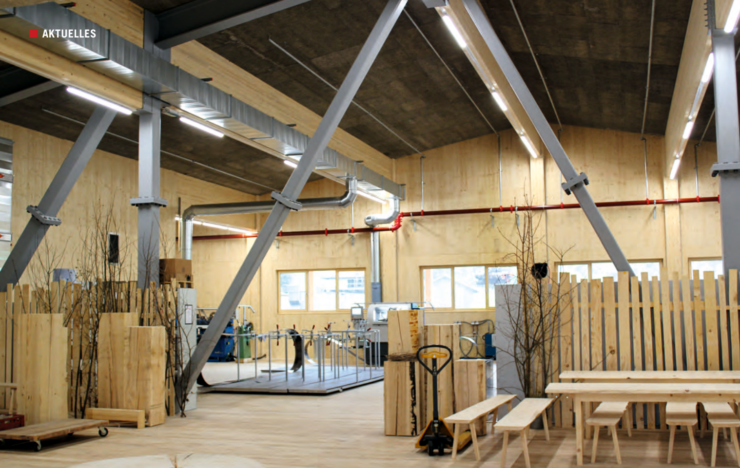
Da der Betrieb des Sägewerks Erhart während der Montage weiterlief, wurde der Wandaufbau mitsamt Innenoberfläche und äußerem Schirm komplett vorgefertigt geliefert.
